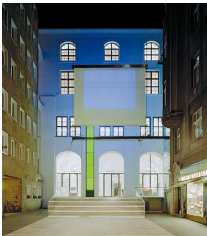
Akademie der Wissenschaften, Alte Aula, Wien 1, Ansicht der Fassade gegen die Wollzeile, Planung: Rudolf Prohazka. Foto: Bruno Klomfar
