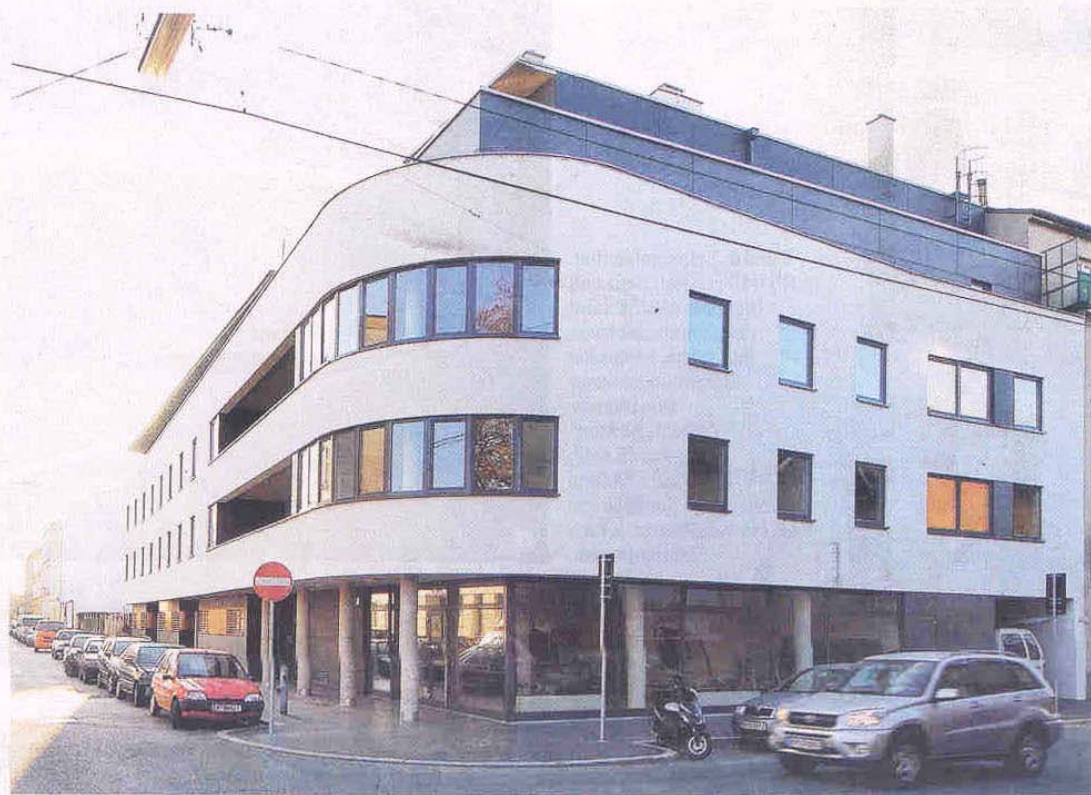
Eine angenehme Rundung betont die Häuserblockecke Stadlauer Straße/Wurmbrandgasse. Das verglaste Lokal unter den Arkaden regt zur Belebung des Straßenraums an. Die gassenseitigen Wohnungseingänge vermitteln ein Gefühl von Individualität.
